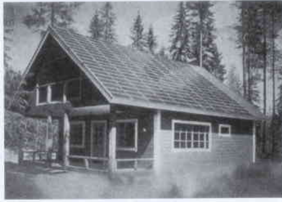
منزل ثانوي في أواسط فنلندا مغطى بكهرباء تولدها منظومة فولطضوية تعطي في الصيف حوالي 5.6 كيلوواط ساعة في اليوم. تؤمن النسائق الفولطضوية على السطح أيضاً وظيفة غطاء وعزل.
