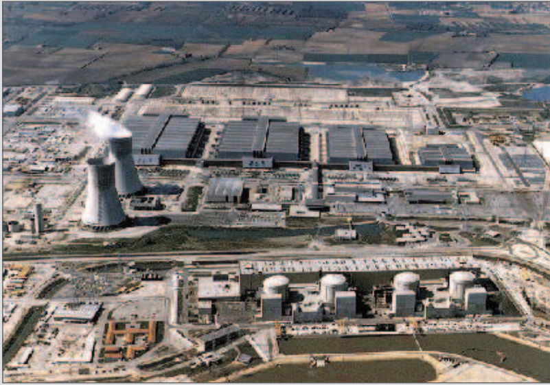
محطة التخصيب George Besse I الكبيرة في تريكاستن بفرنسا (إلى جانب أبراج التبريد). توفر لها المفاعلات النووية الأربعة ما يزيد على 3000 ميغا واط كهربائي.
