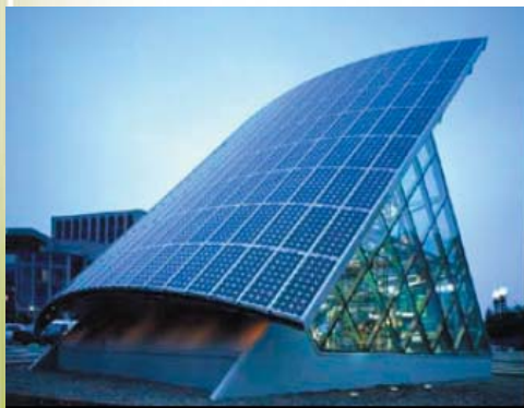
الشكل (9): يمثل مجموعة من الألواح الشمسية المصنعة من سليكون بلوري
