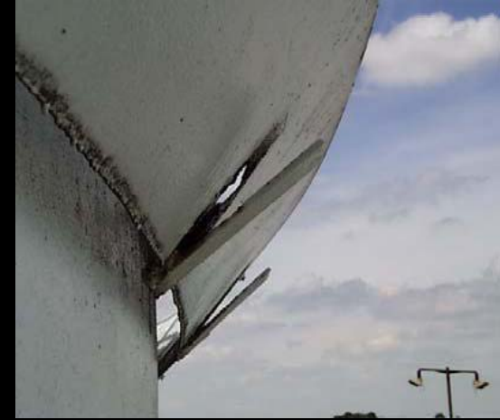
تأذي قاسي لعارضة ريح الخزان بسبب التآكل الجوي
