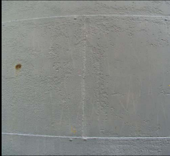
تآكل تقري (نخور) على جدران الخزان سببه التآكل الجوي
