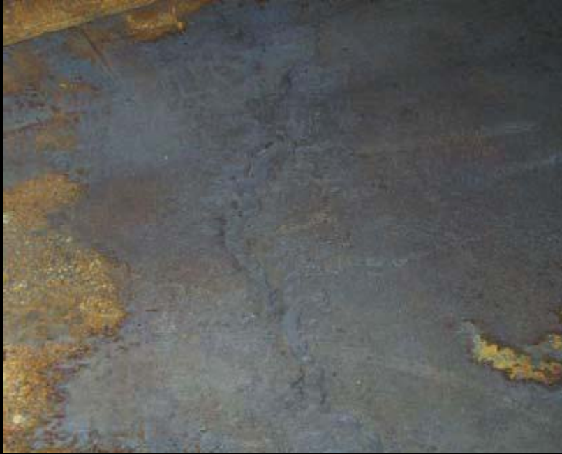
تآكل عام وتمييزي مؤثر على السطح العلوي لأرضية الخزان
