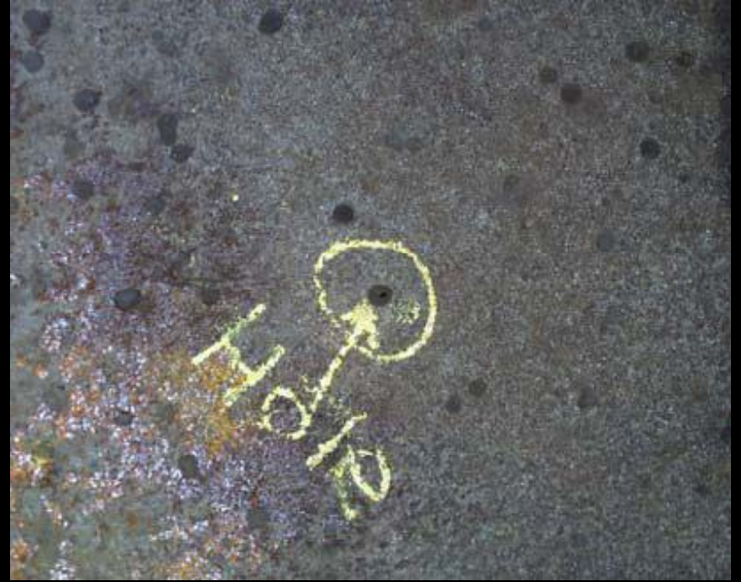
تآكل نقري (نخر) على السطح العلوي أدى لتشكل فتحات على أرضية الخزان
